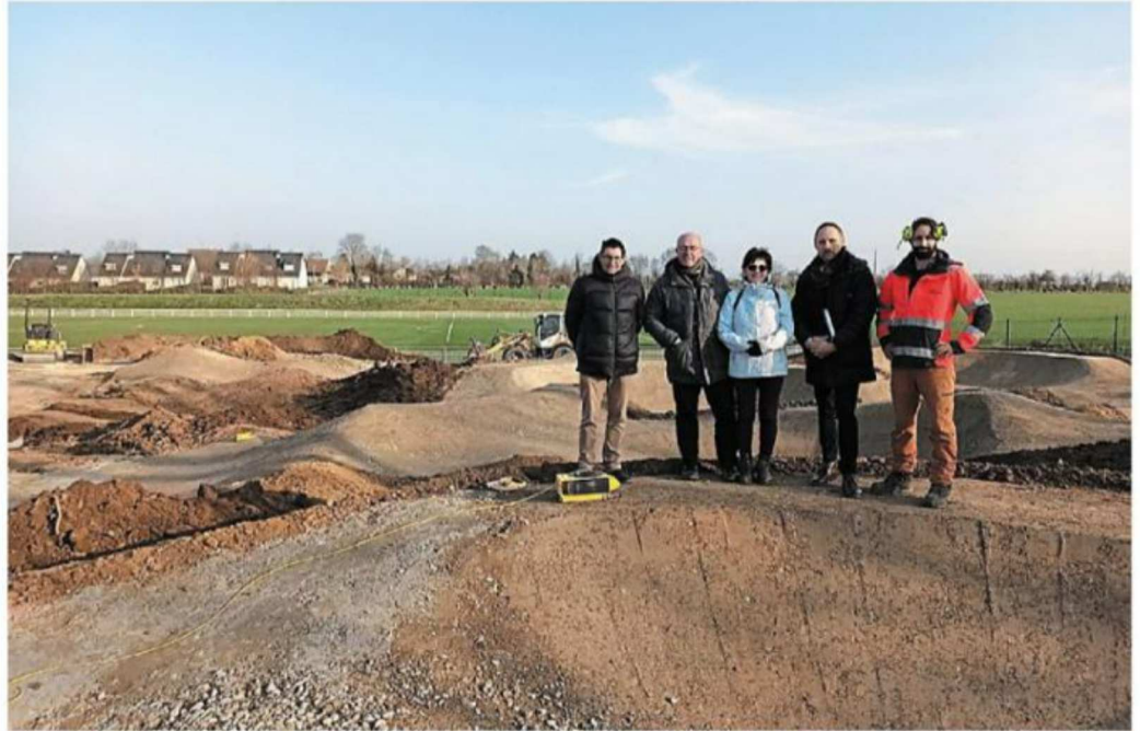
Le maire de Saint-Sylvain et ses adjoints, avec Pierre Supper, chargé de projet de Bike solutions, sur le site du pumptrack en cours de réalisation.
